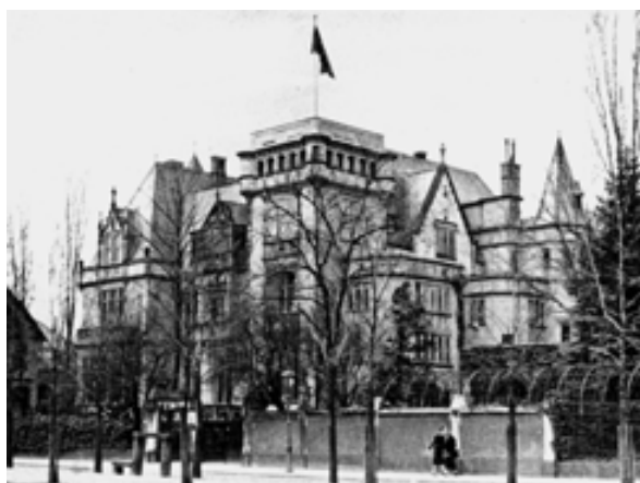
1937 wurde Dessauers »Institut für Physikalische Grundlagen der Medizin« in »Kaiser-Wilhelm-Institut für Biophysik« umbenannt. Ende 1938 zog das Institut von der Weigertstraße 3 (eine ehemalige Stichstraße vom Theodor-Stern-Kai auf das Klinikumsgelände) in die Forsthausstraße 70 (heute Kennedy-Allee) um. Die Aufnahme zeigt die Villa im Jahr 1914.
